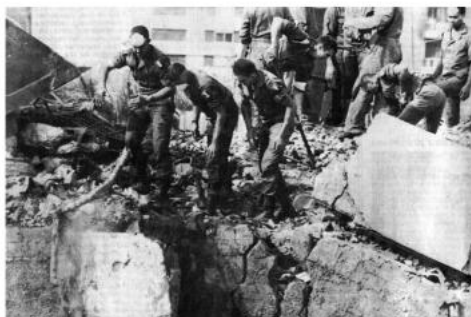
La recherche des corps dans les décombres du Drakkar.
